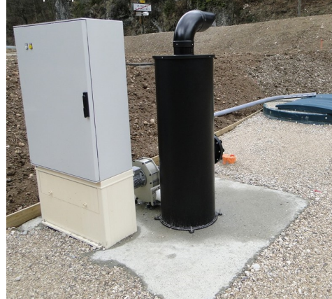
Armoire électrique, filtre à charbon et trappe des pompes
