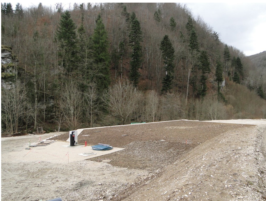
Enrochement côté Bourne
