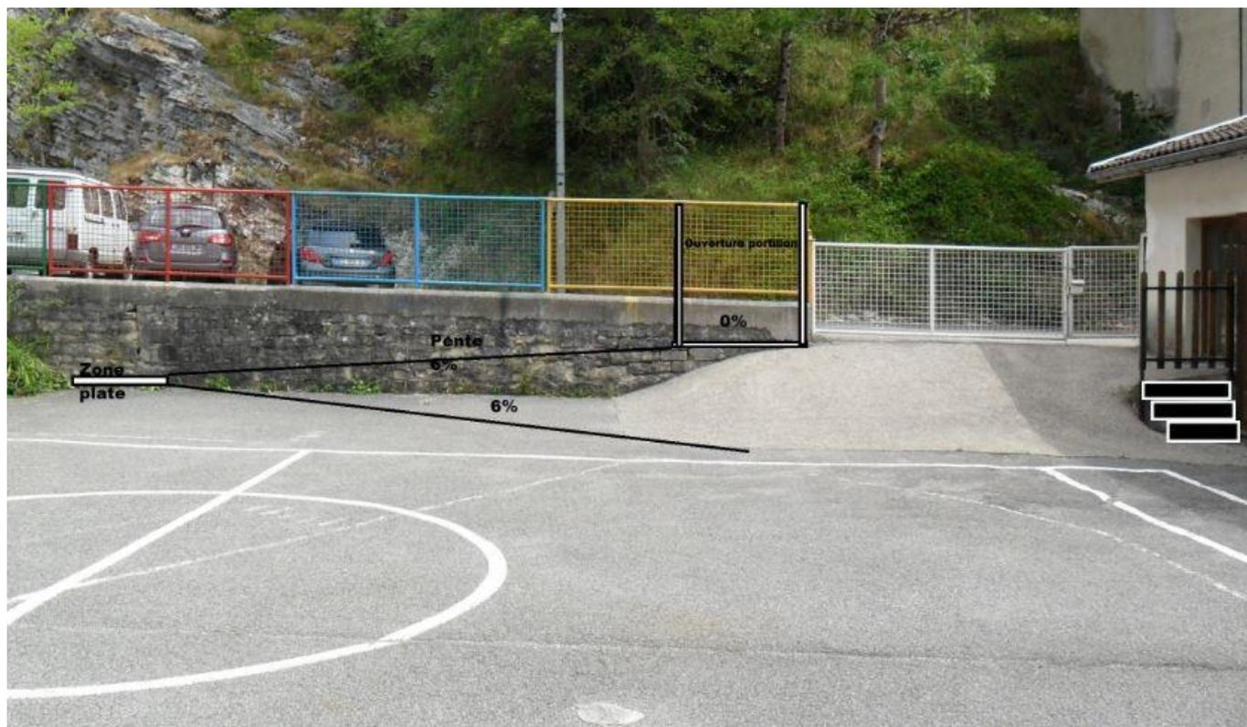
Trois marches seront créées dans le renforcement de la porte d'entrée principale de la salle du Coucourou. Une mise à niveau de la cour le long de la salle du Coucourou sera effectuée afin de supprimer le rebord qui ne permet pas un accès en fauteuil.
