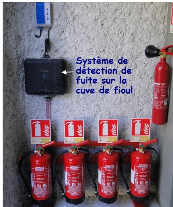
Système de détection de fuite sur la cuve de fioul
