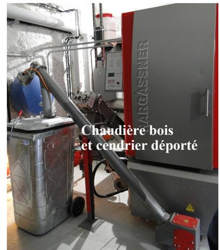
Le bâtiment accueille le local technique de la chaufferie d'une superficie de 45 m<sup>2</sup> (chaudières, ballon tampon, pompes, régulation ...) et le silo de stockage du bois déchiqueté d'un volume de 90 m<sup>3</sup>. Son ossature est entièrement en béton, murs et toiture. L'habillage extérieur est composé de bardage bois, de murs bruts peints (rouge et gris), d'éléments métalliques rouges (trappe d'accès au silo, porte de la chaufferie) et de panneaux
