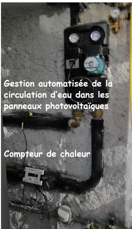
Gestion automatisée de la circulation d'eau dans les panneaux photovoltaïques
