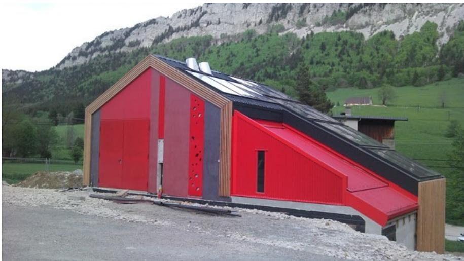
Les travaux de la chaufferie ont repris au printemps et de nombreuses tâches ont été réalisées : étanchéité du toit, bardage bois côté nord, trappe du silo, panneaux solaires côté sud, peinture, raccordement hydraulique des chaudières...
